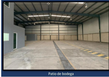
Patio de bodega
