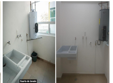
Cuarto de lavado
