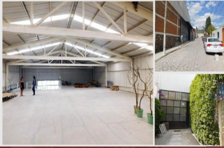
Bodega Santa Rosa Jáuregui
