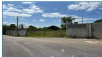
ACCESO A PREDIO
