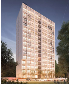
Pre-construcción Colonia Providencia Guadalajara Pre-construcción Providencia neighborhood Guadalajara
